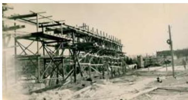
Строительство завода. 1958 год
