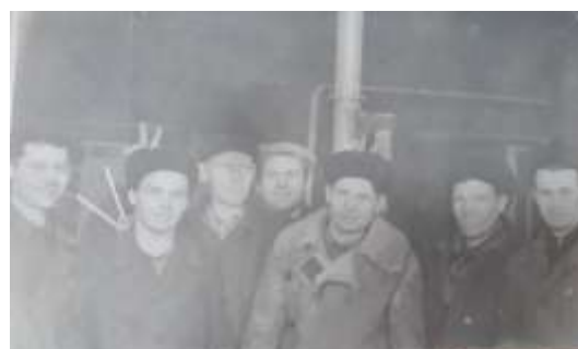
Строительная бригада. 1958 год
