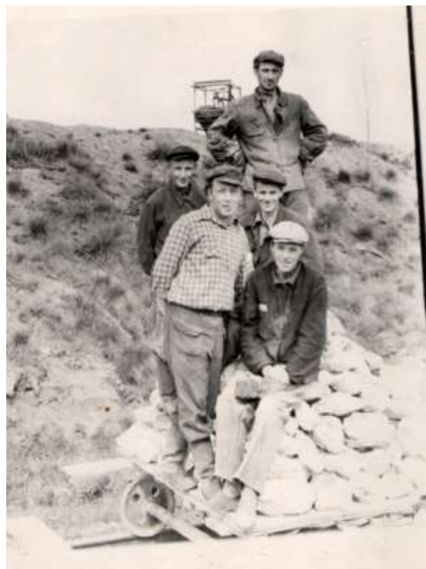
Строительство начиналось с нуля
